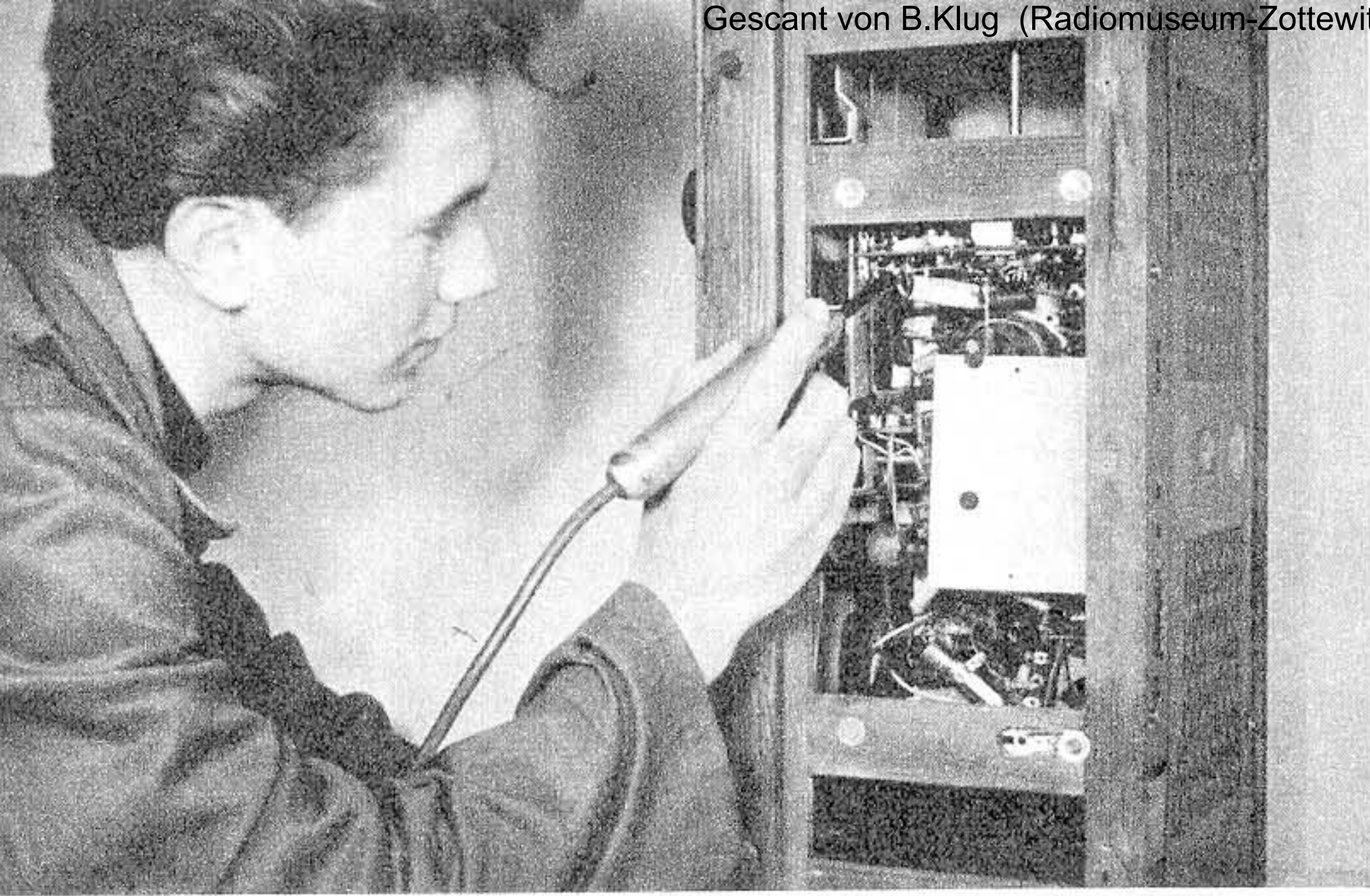
Abb. 1. Fehlersuche, mit dem betriebsfertigen, kleinen Multivibrator
